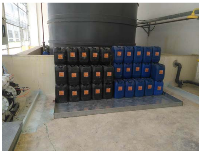
图 4.1-7 危废贮存场所现场图
